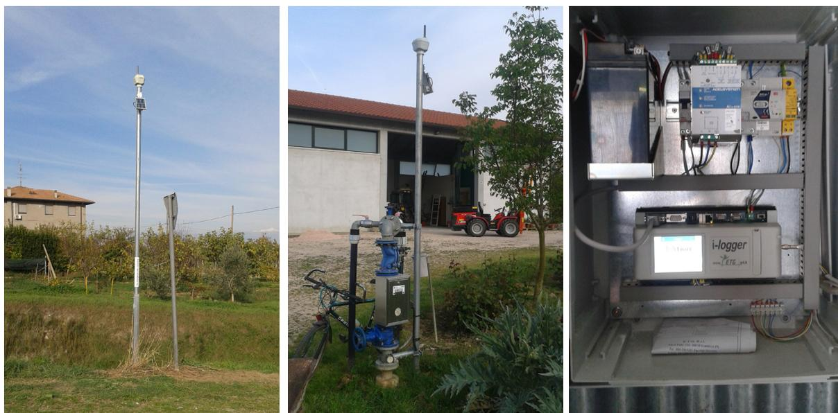
Figura 1: Ripetitore radio in banda libera | Figura 2: Gruppo di consegna | Figura 3: Concentratore
